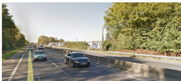
1 Vue du site à partir de la RN4
