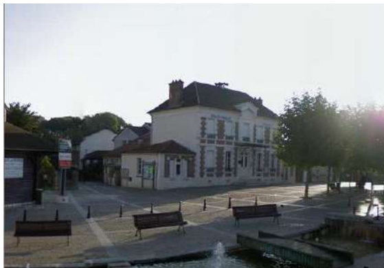
La bibliothèque place du Général Leclerc
