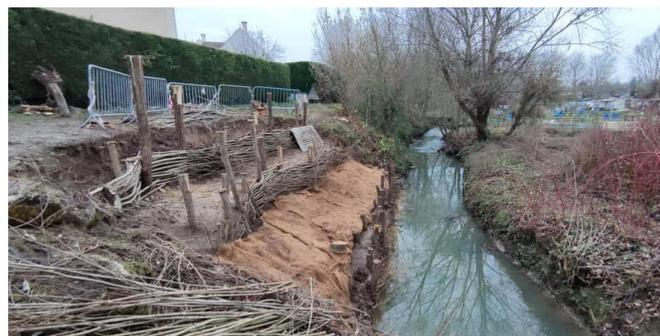
Figure 4 : Travaux de remise en état de la berge dans le quartier des Hantes [source : Pontault-Combault Patrimoine déc. 2021]
